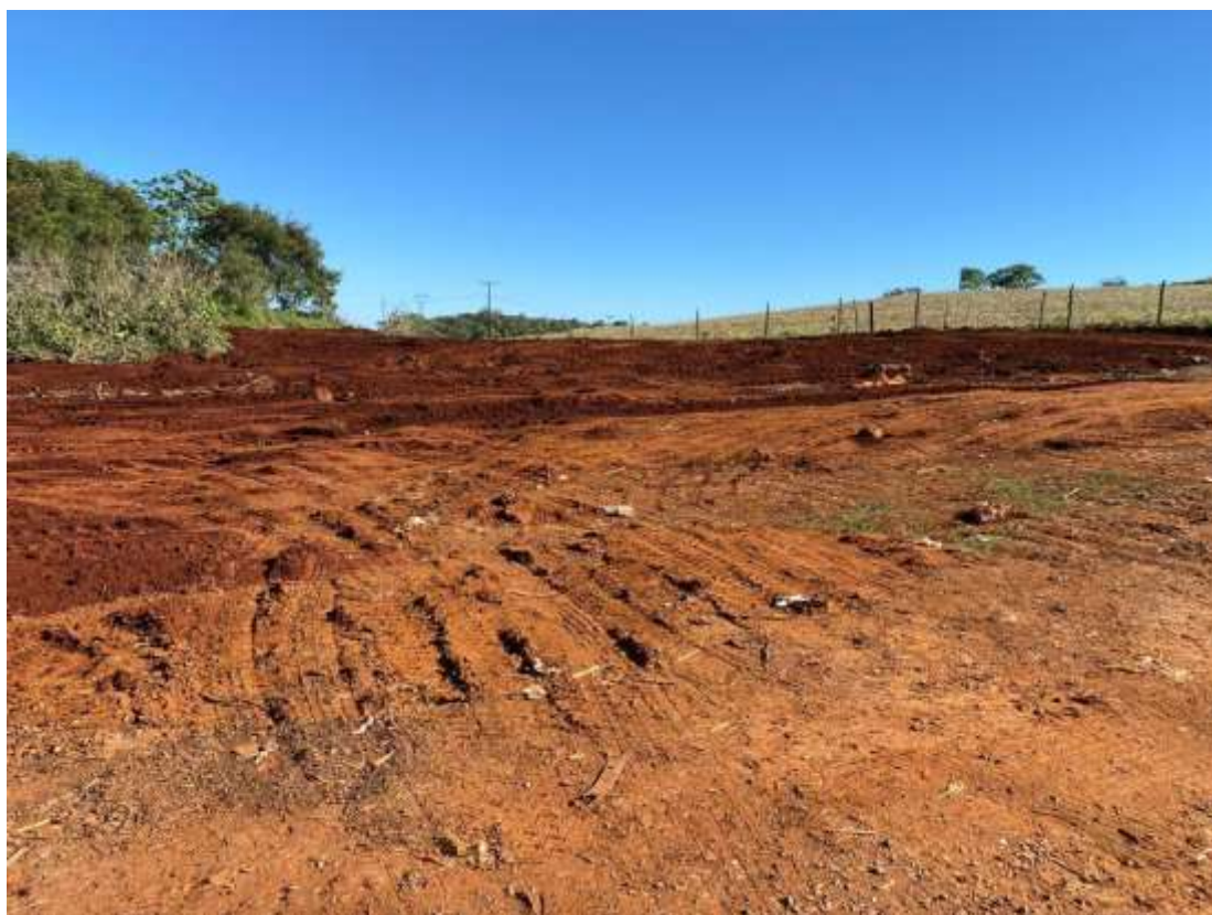
Figura 42-Área em recuperação ambiental de Três Barras do Paraná /PR, antigamente utilizada como local de disposição final de resíduos sólidos urbanos.
